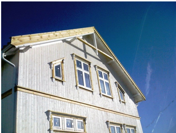
Restaurering av gammel hovedbygning. Foto Bård kollerud
